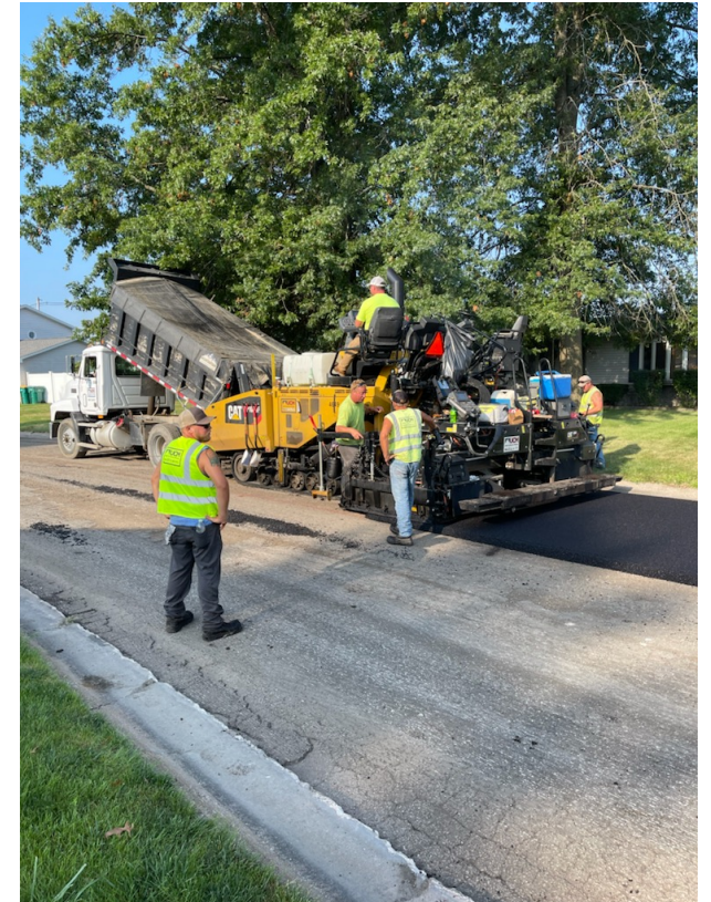
N. MONROE ST RESURFACING - 2021
